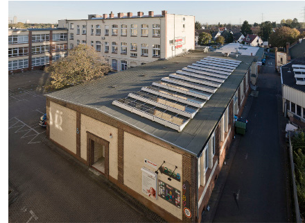
Frankfurt a.M., Westerbachstraße
